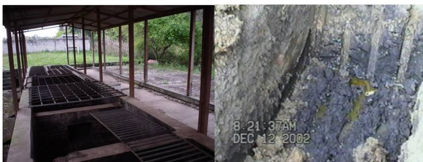
Figura 3: Retirada das caixas de separação água/óleo.
