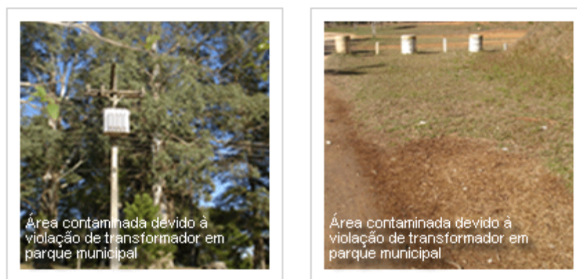
Figura 4. Área contaminada devido à violação de transformador em parque municipal.
