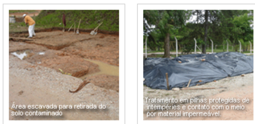
Figura 5. Área escavada para retirada do solo contaminado e tratamento em pilhas protegidas de intempéries e contato com o meio impermeável.
