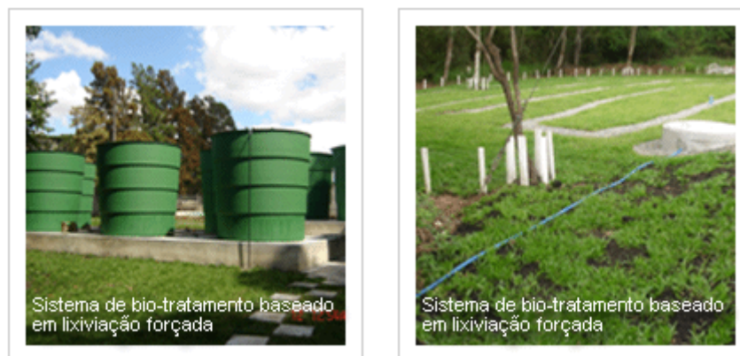
Figura 2. Sistema de bio-tratamento baseado em lixiviação forçada.
