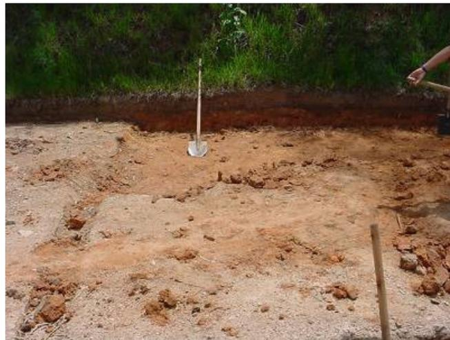
**Figura 3.** Retirada de mais 20 cm de solo contaminado.
