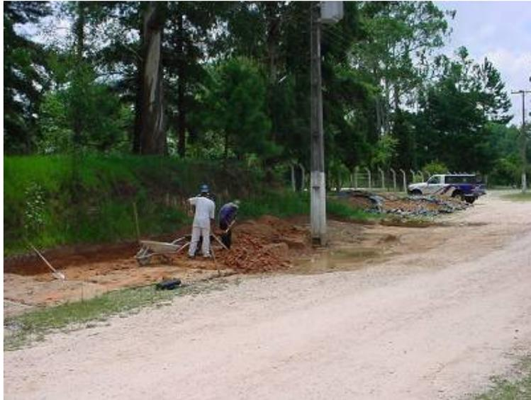
**Figura 2.** Retirada do solo contaminado.
